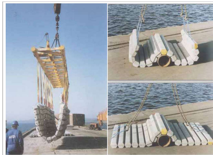
FIGURE 18 : MATELAS BETON TRANSPORTE (GAUCHE) ET DEPOSE SUR UNE CONDUITE (DROITE) (SOURCE : BERR 2008)
