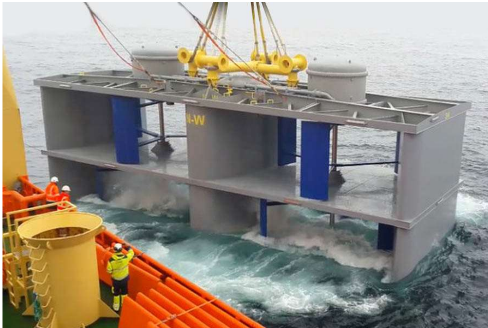
FIGURE 10 : IMMERSION DE L'HYDROLIENNE D'HYDROQUEST AU LARGE DE PAIMPOL (PRINTEMPS 2019)
